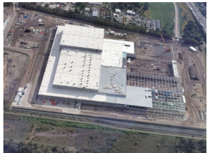
Bild 4 Zentrallager EDEKA Oberhausen Central warehouse EDEKA Oberhausen
