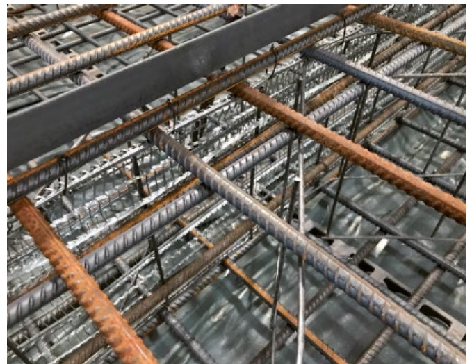
Bild 7 Detail Abstellung Tagesfeld Detail separation day field
